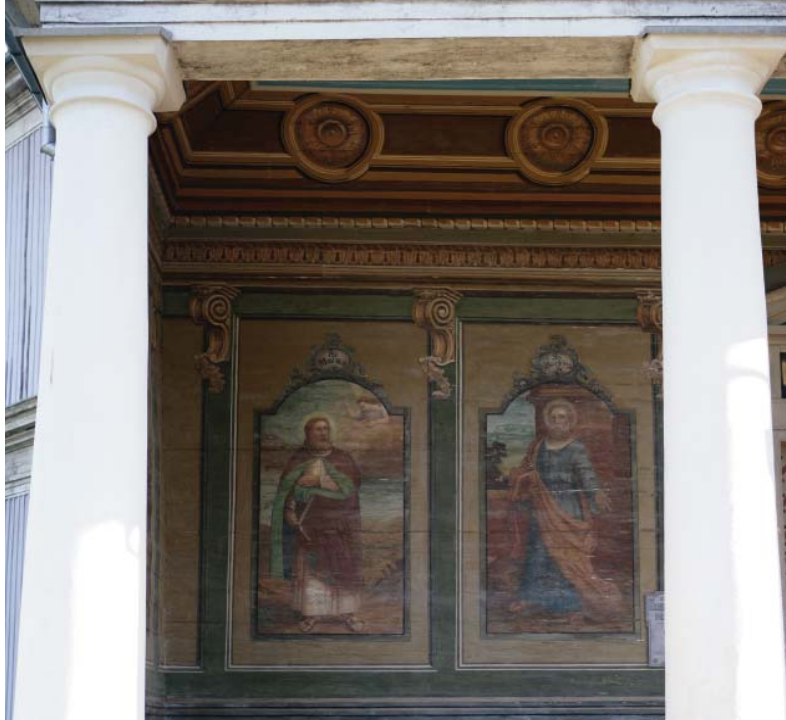
Griškabūdžio Kristaus Atsimainymo bažnyčios fasadas, Šakių r. Facade of the Church of Christ's Transfiguration, Šakiai District
